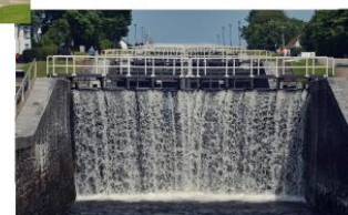
NEPTUNE'S Staircase, sortie du canal Calédonien
