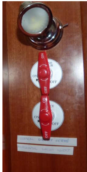
Poignées verticales circuit fermé : Le courant passe
