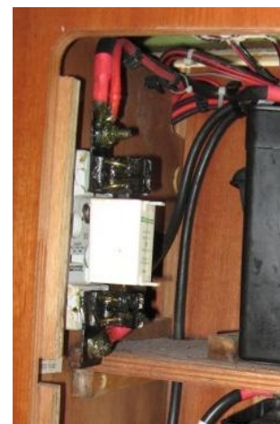
Porte fusible à couteaux Fusible 100 A
